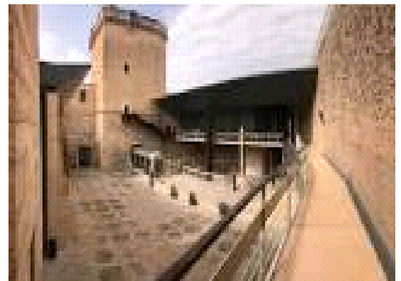
Patio de armas Palacio de Altamira
